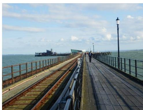
本桟橋は、延長 2200m、英国のみならず世界で一番長いプロムナード桟橋である。最初の桟橋は 180m の木造で 1830 年に供用開始した。しかし干潮時には船が着桟できぬため延伸を重ね、1846 年までには 2133m に達していた。
